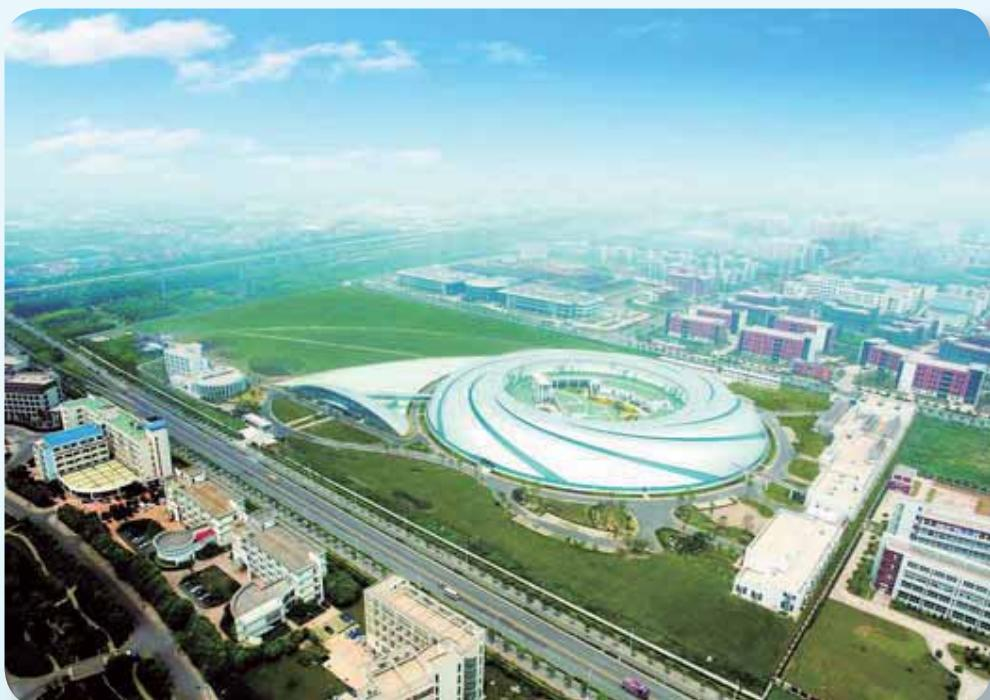
上海光源，即 SSRF (Shanghai Synchrotron Radiation Facility)，是我国跨世纪最大的科学工程，投资逾 12 亿人民币，2004 年 12 月开工，坐落上海张江高科技园区。作为国家级大科学装置和多学科的实验平台，上海光源由全能量注入器（包括 150MeV 电子直线加速器、周长 180 米的全能量增强器和注入／引出系统）、电子储存环（周长 432 米，能量 3.5GeV）、光束线和实验站组成。
